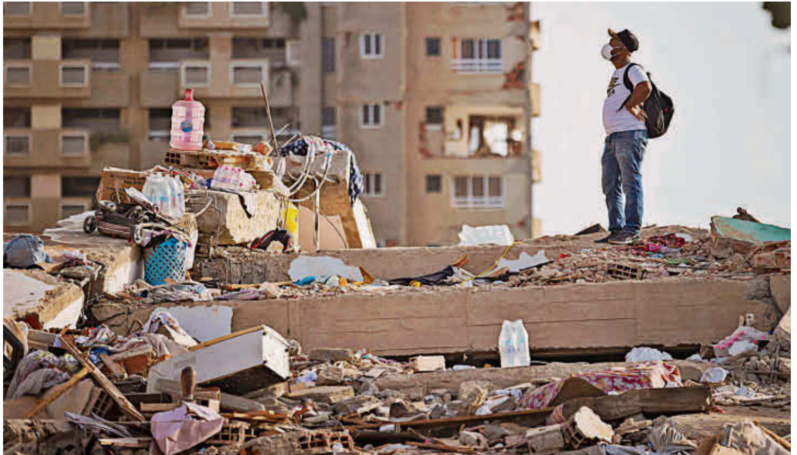
Una persona busca señales de vida sobre los escombros de un edificio derrumbado en Catia La Mar. EFE
